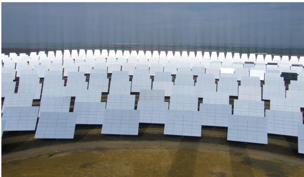
**Figura 0.1** Campo de heliostatos al que algunos periodistas llaman instalación fotovoltaica.
